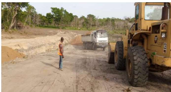
Travaux d'aménagement du barrage de Toro Kinkéné
